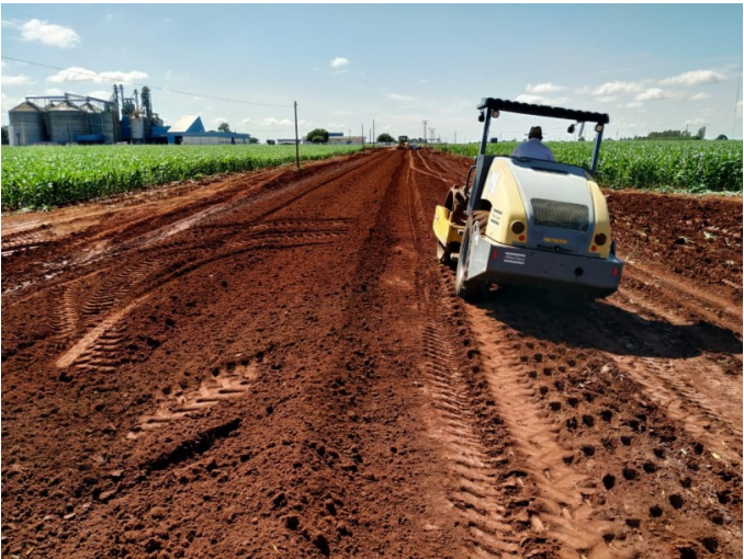
Figura 5: Compactação com rolo da estrada
